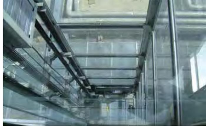
Estructuras autoportantes pensadas para solucionar la instalación de ascensores en lugares dónde no existe hueco con paredes resistente, o se anexan exteriormente a los edificios. Resistentes y sólidas, pero adaptables en estética. De chapa, de colores, de inoxidable, de cristal.
